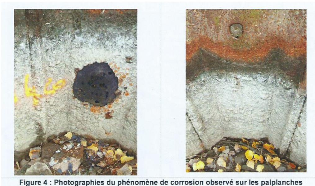
Figure 4 : Photographies du phénomène de corrosion observé sur les palplanches
